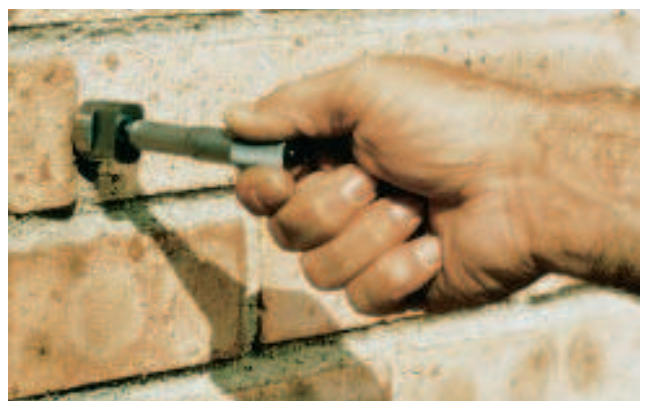
Midiendo Micrómetro de aguja midiendo la profundidad de una penetración de clavo en una junta de argamasa
