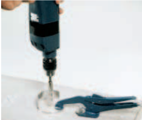
Acumulando polvo de taladro para una muestra
